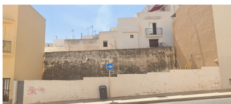
Possible tros de muralla del carrer Muret.
